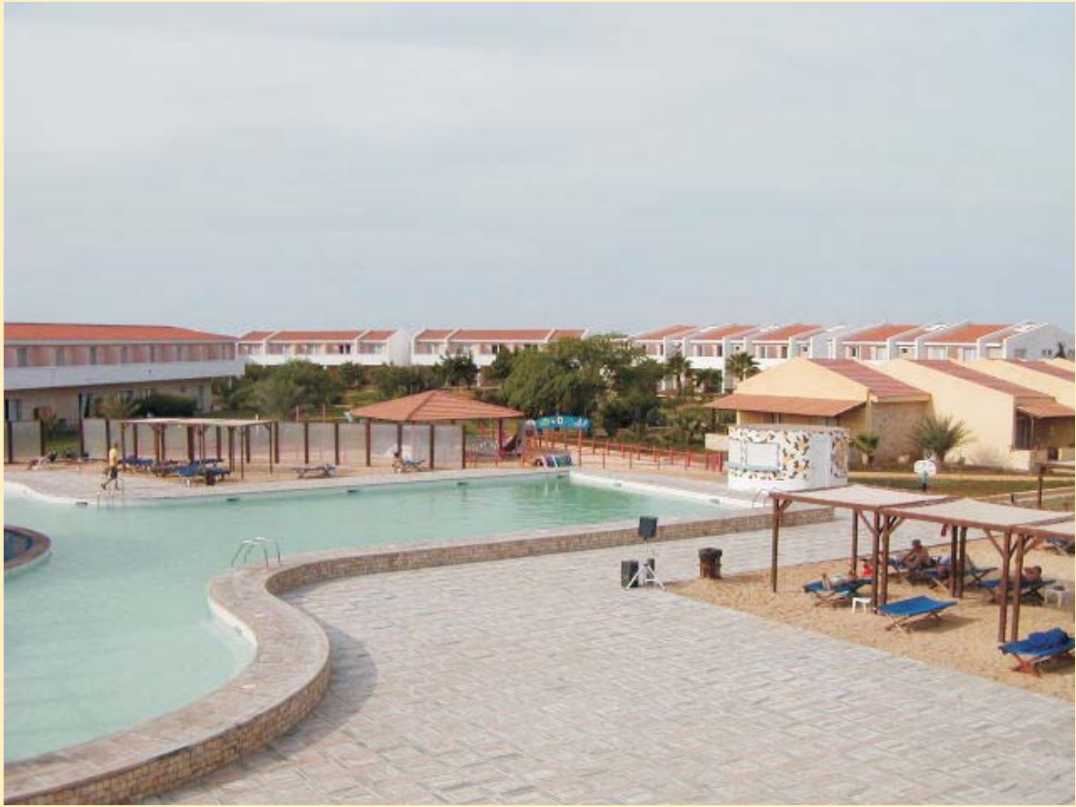
Vista area piscina (con acqua di mare)
