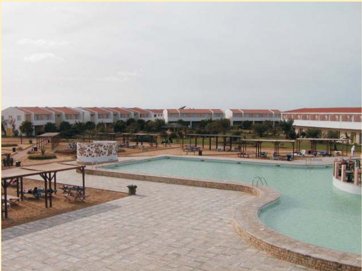
Vista area piscina (con acqua di mare)
