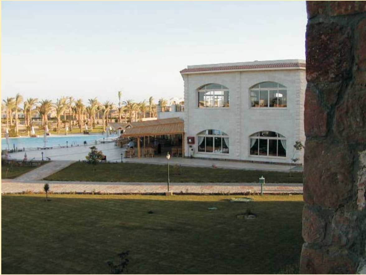
Edificio ristorante + area ristorante all'aperto
