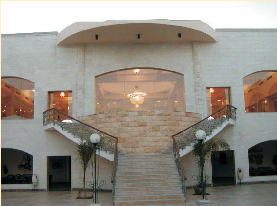
Accesso interno alla hall
